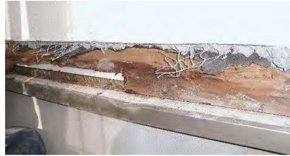
**写真 3.3.4 モルタル外壁土台水切りの腐食**
