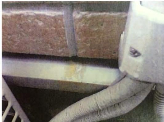
写真3.3.1 漏水による土台水切りの腐食例
