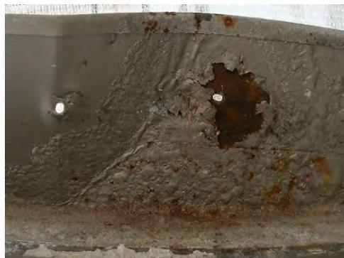
**写真 3.3.6 腐食した水切りの釘孔周辺の状況**
