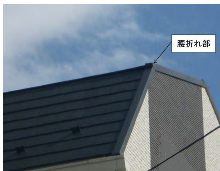
写真 3.4.13 マンサード屋根
