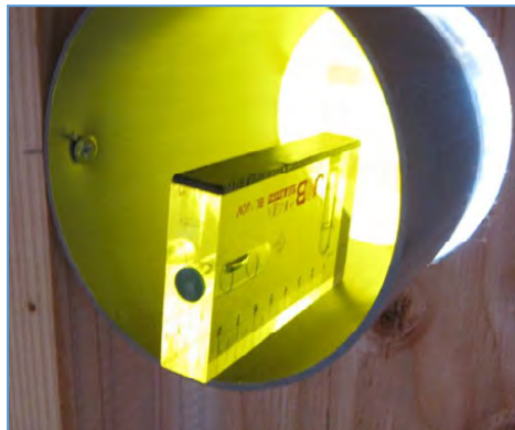
写真 3.5.2 換気ダクト 外下がり取付勾配確認
