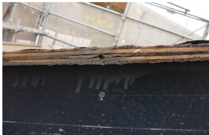
写真 3.4.21 けらば水切りを合板木口面に留めた釘孔
