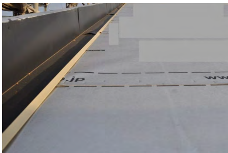
写真 3.4.6 片流れ屋根（けらば部、流れ長さが長くなっている状態）
