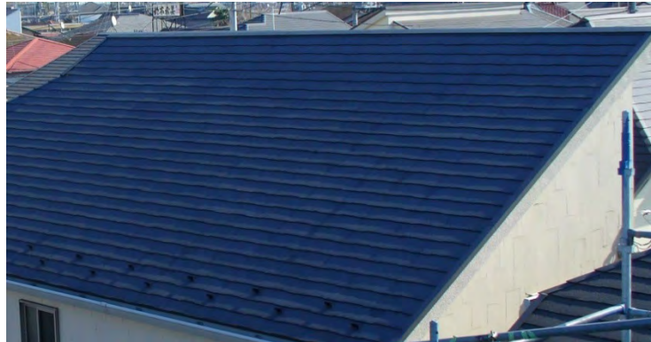
写真 3.4.7 片流れ屋根（北面・6 寸（ 30^{\circ} ）勾配）
