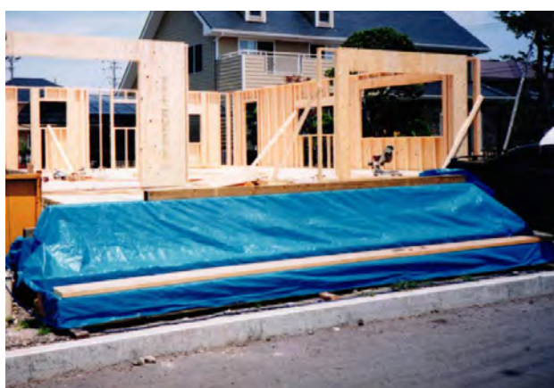
写真 3.2.1 木材の現場保管の例
