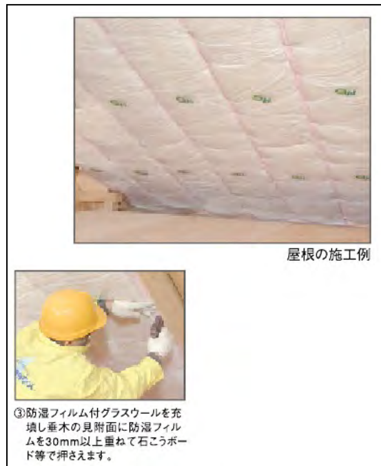
写真 3.4.17 屋根断熱構法の防湿層施工
