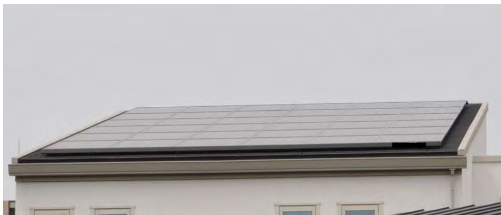
写真 3.4.8 片流れ屋根（南面・太陽光パネル設置）
