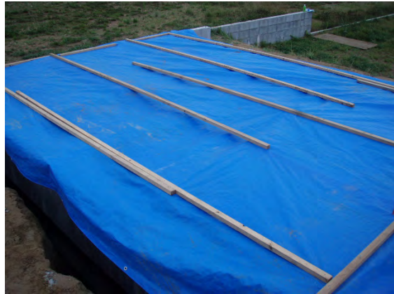
写真 3.2.3 施工現場での養生例
