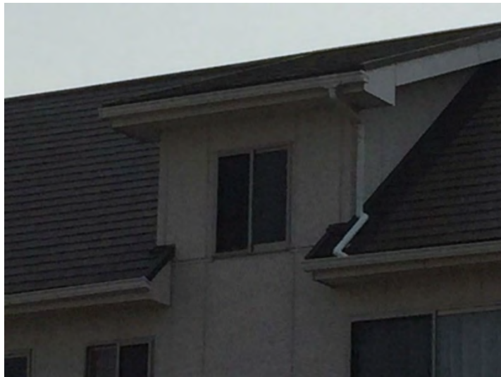
写真 3.4.19 小屋裏空間利用（小屋裏空間と屋根断熱が入り組む）
