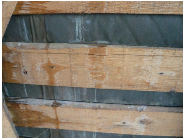
写真 1.4.1 モルタル外壁解体調査事例
