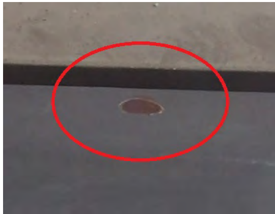
写真 3.4.10 滴下水によるエロージョン事例
