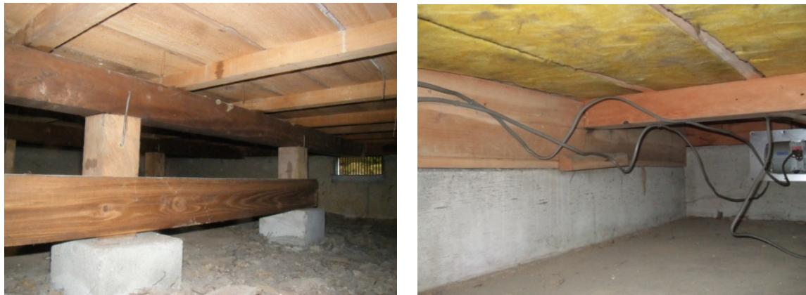
写真 6.3.2 在来軸組構法による 1 階床下例（左：布基礎 右：ベタ基礎）
