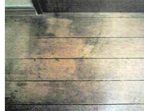
化粧フロア材のカビによる変色
