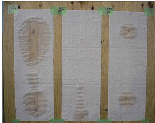
写真 8.4.2 透湿防水シート取り外し（散水後）
