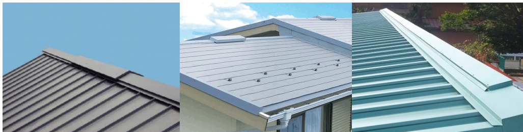
写真 4.1.3 棟換気部材の例
