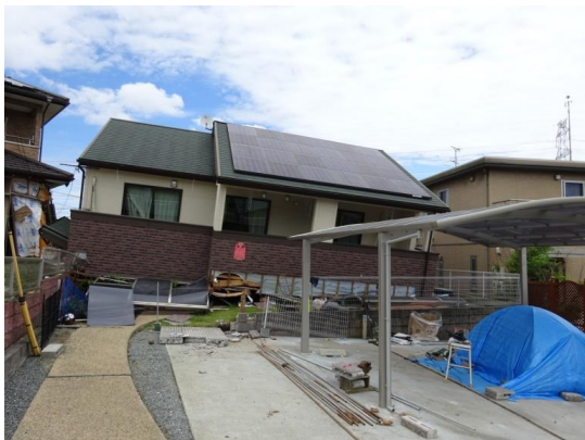
写真4 倒壊した木造住宅
