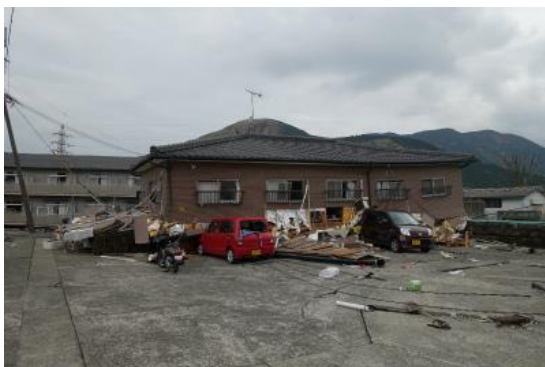
写真14 倒壊した木造アパート
