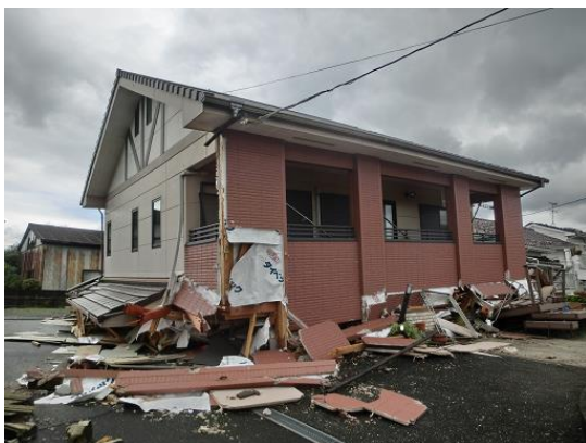
写真6 倒壊した木造住宅
