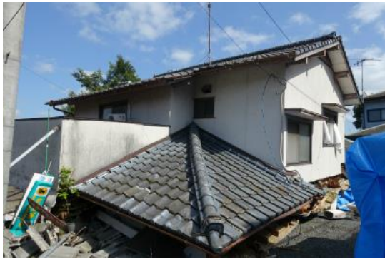
写真2 倒壊した木造住宅
