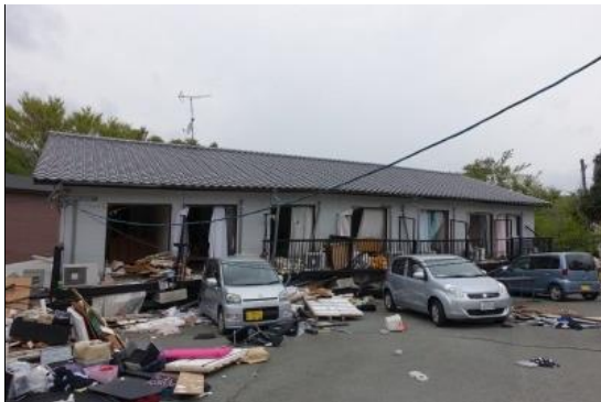
写真12 倒壊した木造アパート
