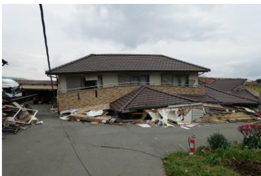
写真16 倒壊した木造住宅
