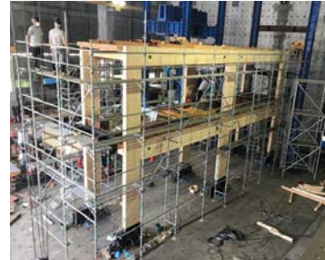
集成材半剛節フレーム構造の部分架構実験
