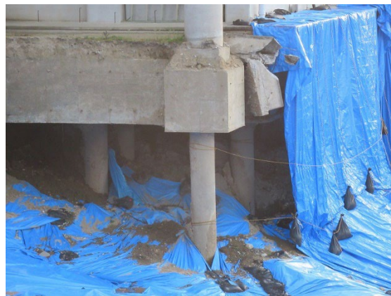
図 4.13.2 杭頭の露出
