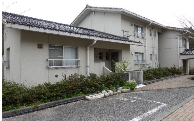
図 5.2.5 県営住宅の外観
