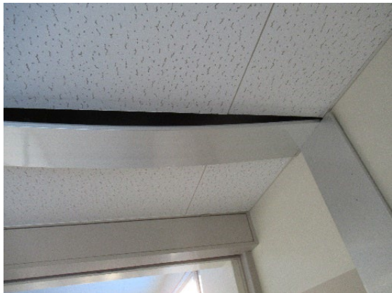
図 4.13.3 Exp. J. の損傷
