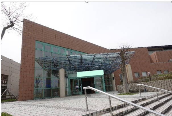
図 5.2.11 建築物 N-1 の外観
