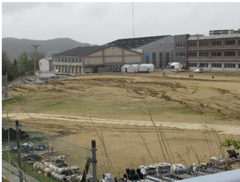
図 5.2.9 周辺地盤の変状
