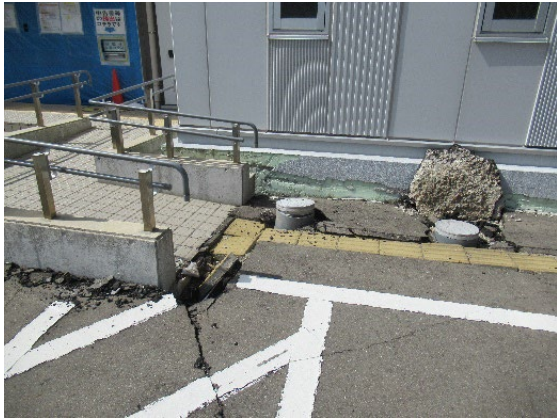
図 4.8.5 建築物周辺の地盤状況
