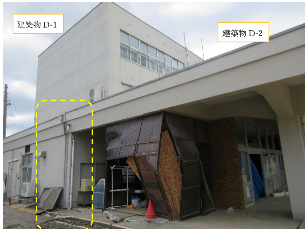
図 4.4.10 建築物 D-1 と建築物 D-2 の Exp. J.
