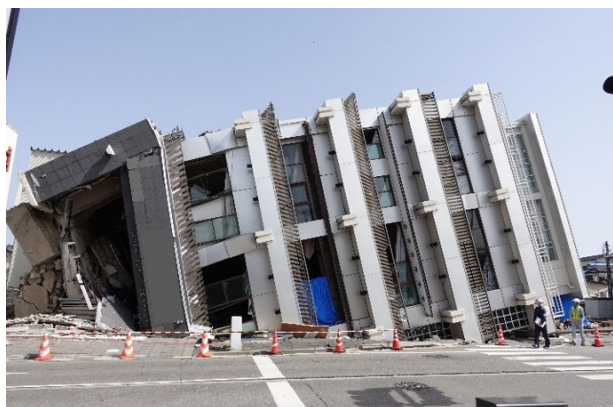
図 4.1.1 建築物外観（南側）
