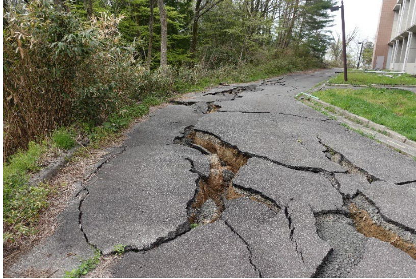
図 5.2.10 建築物 N-1,N-2 周辺の地盤変状
