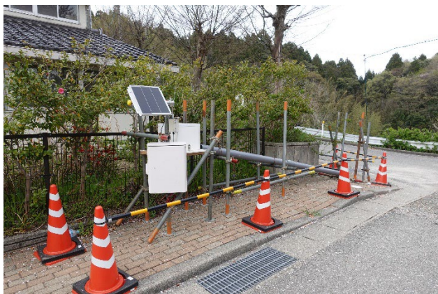
図 5.2.4 地盤変位のモニタリング
