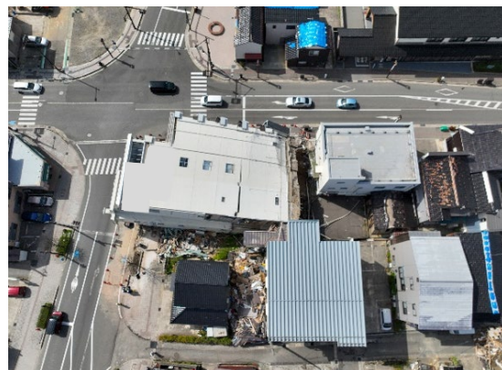
図 4.1.2 建築物外観（西側）
