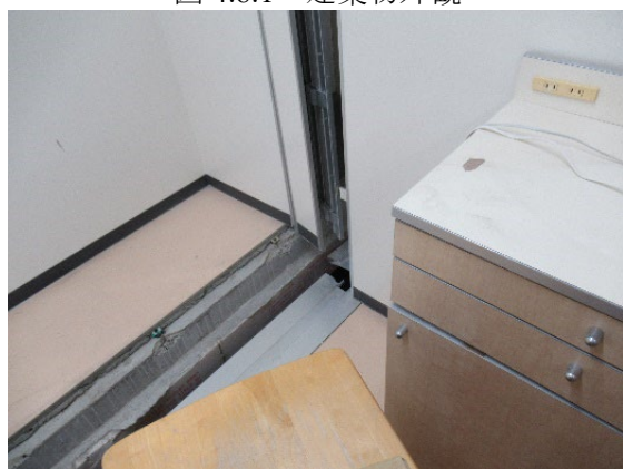
図 4.8.3 Exp. J.の損傷②
