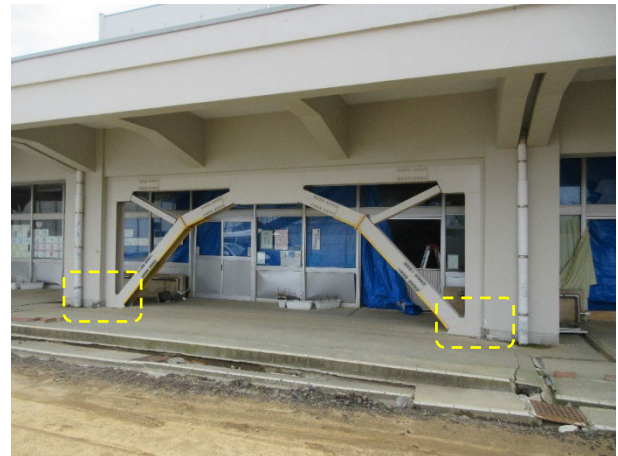
図 4.4.11 建築物 D-2 の鉄骨ブレース補強
