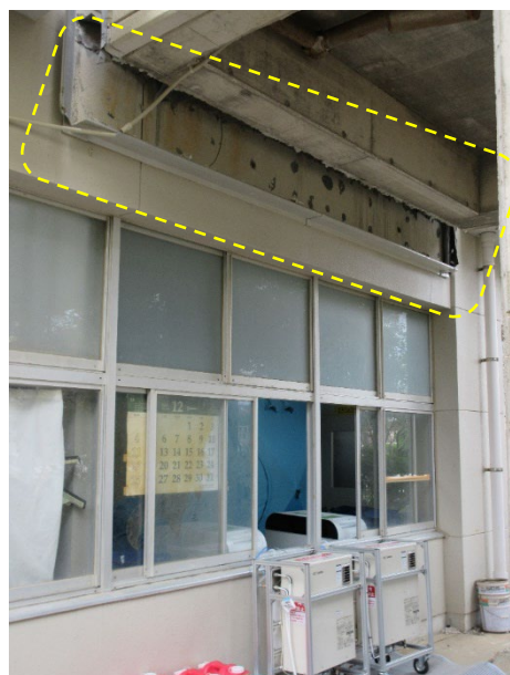
図 4.4.17 建築物 D-4 と別棟の Exp. J.のずれ
