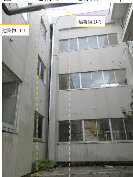
図 4.4.14 建築物 D-1 と建築物 D-3 の Exp. J.
