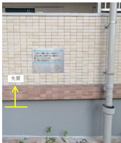
図 4.3.1-1 免震表示（クリアランス 35cm）
