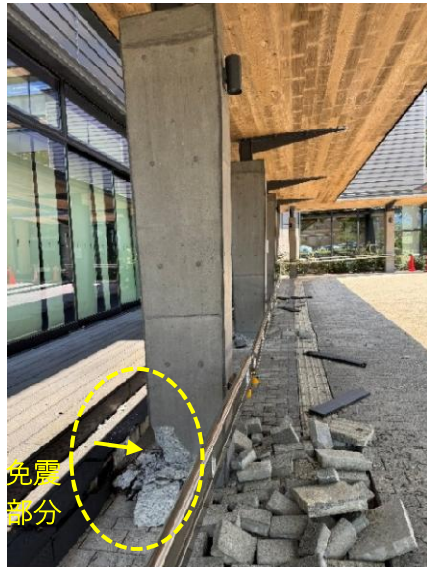
図 4.1.1-13 キャンピーの柱の破損 図 4.1.1-14 階段手すり部の変形 (B1 階)
