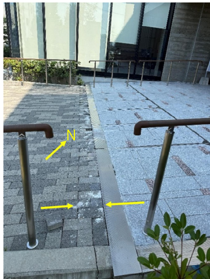
図 4.2.1-6 エキスパンションカバーの移動痕
