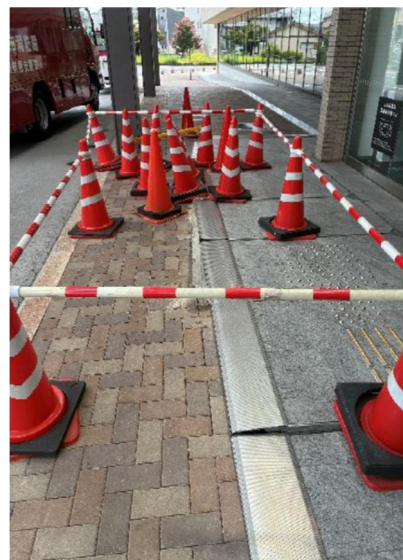
図 4.2.4-3 エキスパンションカバーのずれ
