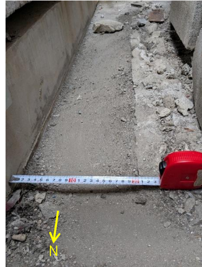
(a) 地震後の状況 (b) 離間及び移動の状況 ((a)の○部の拡大)
