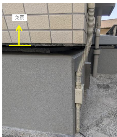
図 4.3.1-2 周囲の配管の状況
