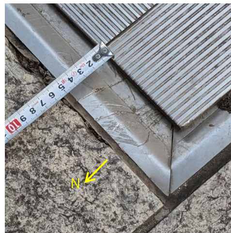
図 4.3.4-1 エキスパンションカバーの変状及び削り跡
