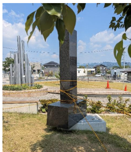
図 4.2.3-7 モニユメントの基部からのずれ
