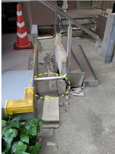
(a) 地震後の状況 (b) 離間及び移動の状況 ((a)の○部の拡大)
