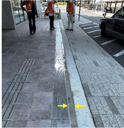
図 4.2.3-8 エキスパンションカバーのずれ
