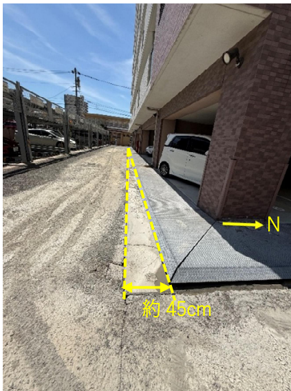
図 4.1.3-3 建物奥側（東側）のカバーのずれ
