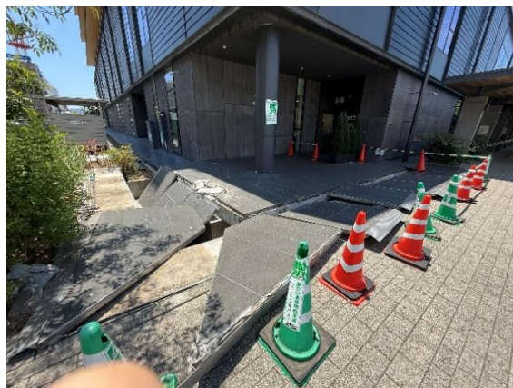
図 4.1.1-3 エキスパンション部のずれ・脱落
