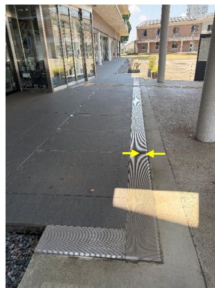
図 4.2.2-5 エキスパンションカバーの移動痕
