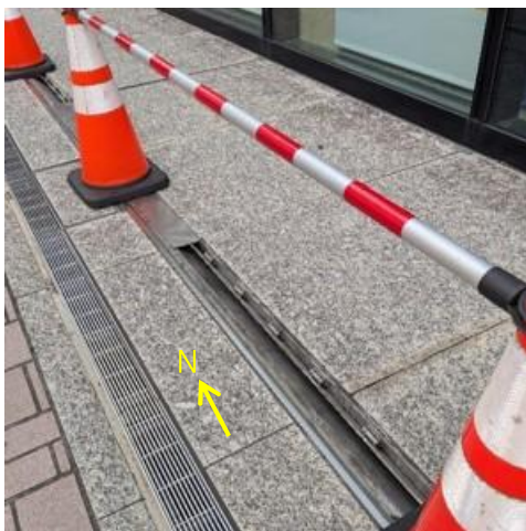
図 4.3.4-1 エキスパンションカバーの変状及び削り跡
