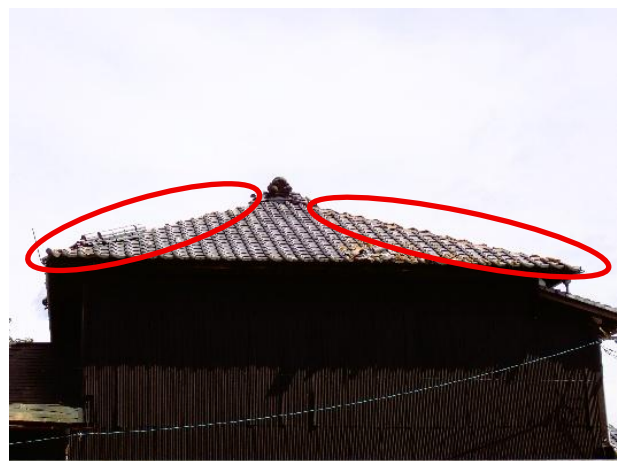
写真 2.2.7 隅棟部の瓦の脱落
