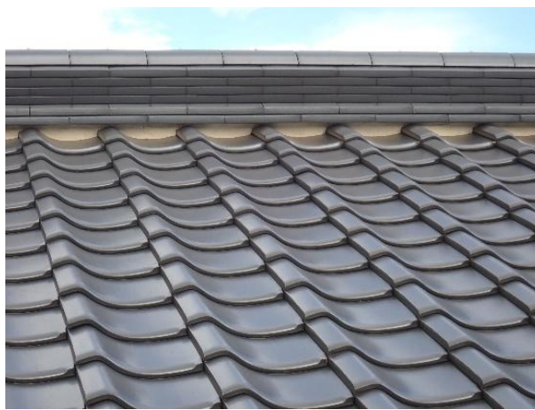
写真 2.3.2 屋根の平部と棟部の状況（住宅 E）
