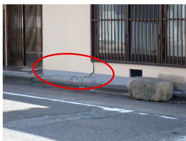
写真 2.2.6 基礎の状況 (住宅 D)
