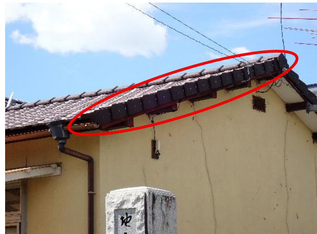
写真 2.2.2 袖瓦の緊結状況（住宅 A）
