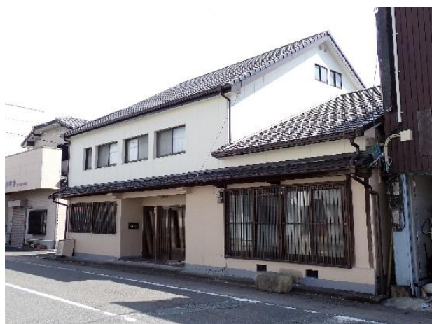
写真 2.2.5 屋根の状況 (住宅 D)
