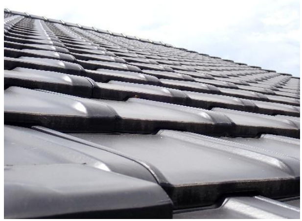
写真 2.3.8 屋根の平部の状況（住宅 F）
