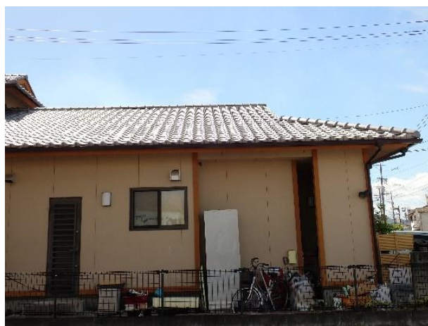
写真 2.2.4 屋根の状況 (住宅 C)
