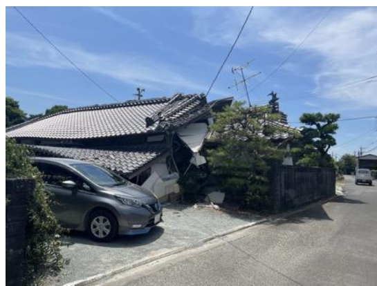
写真 7.2.6a 築年数 80 年以上の木造住宅 の倒壊
