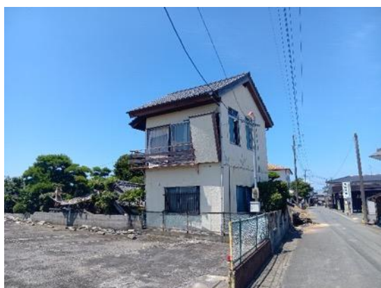
写真 6.2.11 残留変形 前面道路並行方向 : 85/1000=1/12\text{rad} 前面道路直交方向 : 88/1000=1/11\text{rad}
