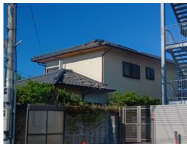
写真 5.2.2 瓦屋根被害
