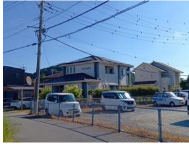
写真 5.2.7 外観上、無被害と 思われる住宅
