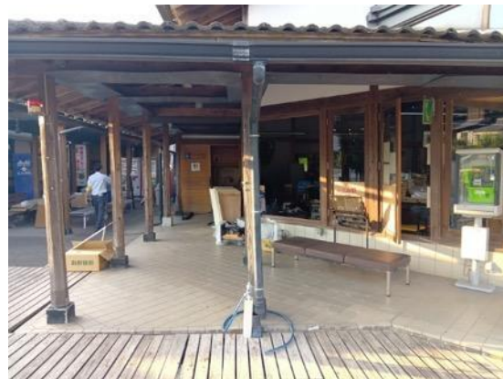
写真 9.2.1b 中規模木造建築物柱の傾斜 1/18\text{rad}
