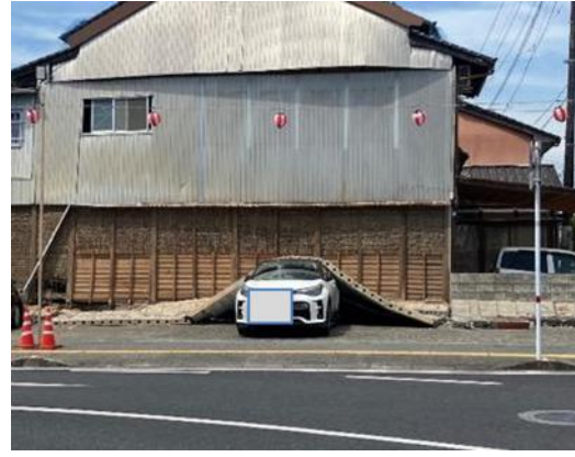
写真 7.2.14 外壁の脱落
