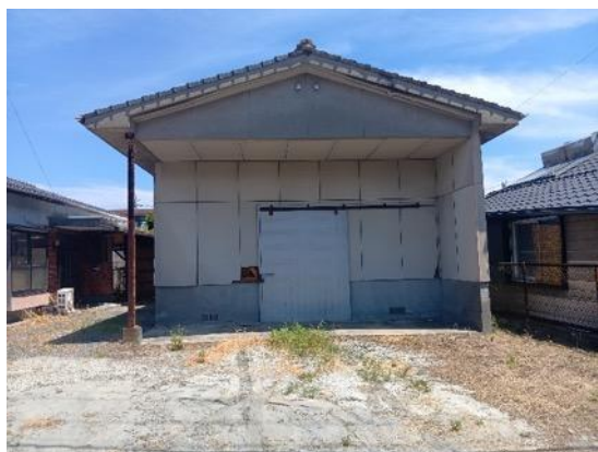
写真 6.2.11 残留変形 前面道路並行方向 : 85/1000=1/12\text{rad} 前面道路直交方向 : 88/1000=1/11\text{rad}
