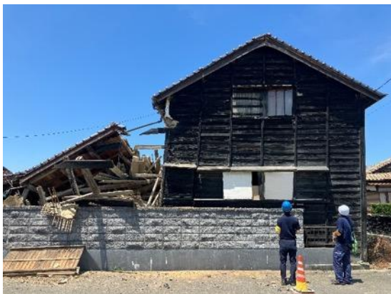
写真 6.2.10 残留変形 81/1000=1/12\text{rad}
