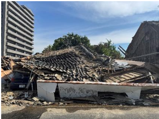
写真 8.2.5 2F 建て住宅の倒壊
