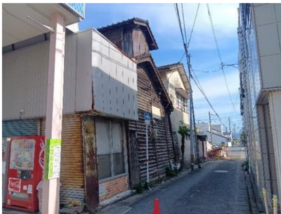
写真 8.2.3 住宅の傾斜
