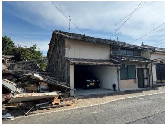
写真 8.2.6 同年代の隣接住宅（倒壊なし）
