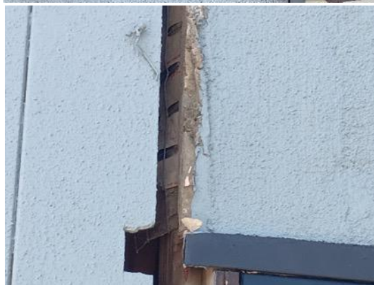
写真 6.2.12 外壁の損傷
