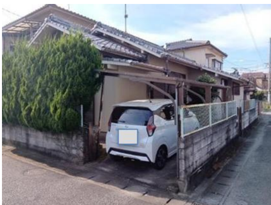
写真 8.2.11 築 40 年程の住宅（外観被害なし）
