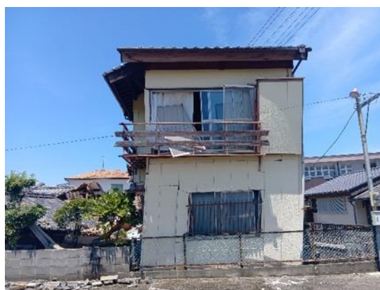
写真 6.2.11 残留変形 前面道路並行方向 : 85/1000=1/12\text{rad} 前面道路直交方向 : 88/1000=1/11\text{rad}
