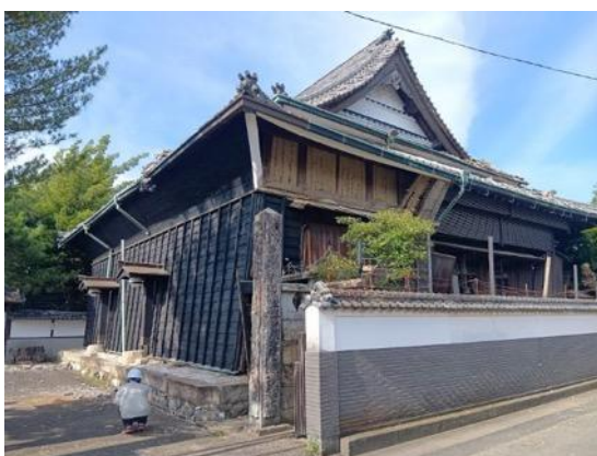
写真 8.2.17 社寺建物の傾斜
