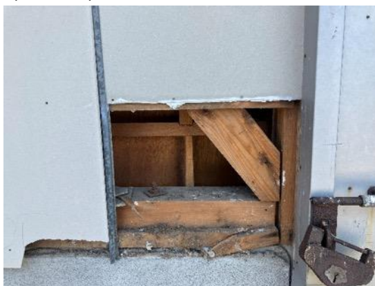
写真 6.2.11 残留変形 前面道路並行方向 : 85/1000=1/12\text{rad} 前面道路直交方向 : 88/1000=1/11\text{rad}
