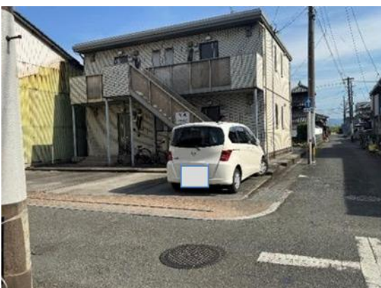
写真 8.2.13 アパート（外観被害なし）
