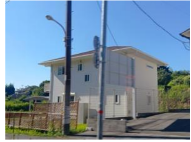
写真 5.2.8 外観上、無被害と 思われる住宅
