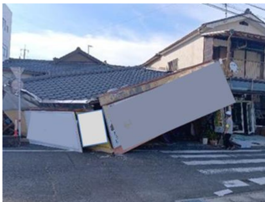
写真 8.2.19 古い店舗の層崩壊
