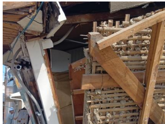
写真 8.2.2 土壁＋筋かい（端部は釘留め）
