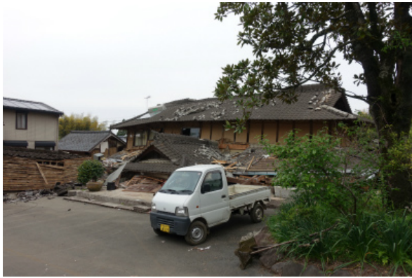
写真 5.3-44 倒壊した木造住宅
