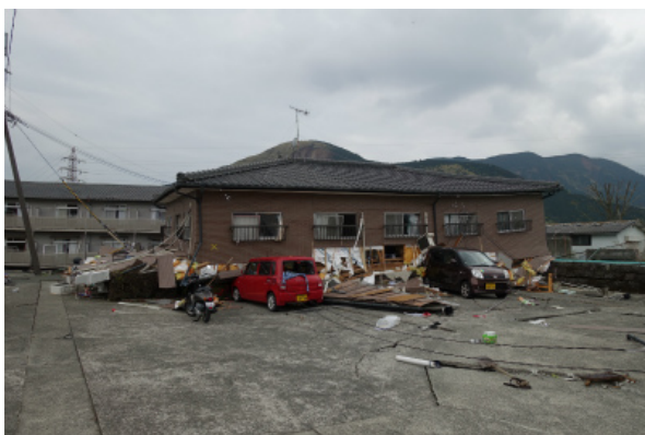
写真 5.3-56 倒壊した木造アパート E
