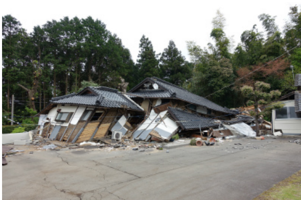
写真 5.3-38 倒壊した木造住宅
