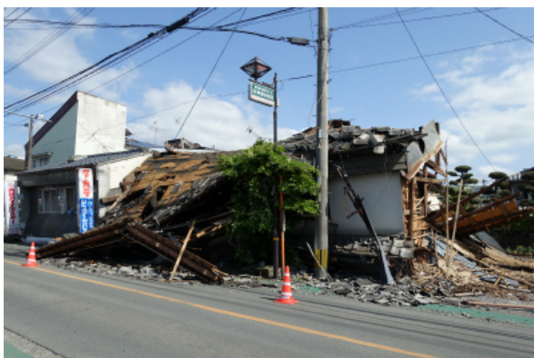
写真 5.3-4 倒壊した木造住宅
