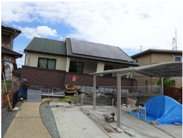
写真 5. 3-18 倒壊した木造住宅
