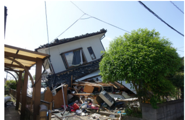
写真 5.3-9 倒壊した木造住宅
