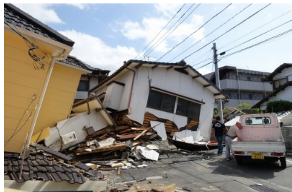
写真 5.3-13 倒壊した木造住宅
