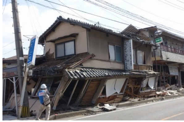
写真 5.3-7 大きく傾斜した店舗併用住宅
