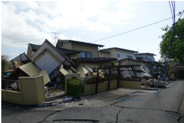
写真 5. 3-16 倒壊した木造住宅
