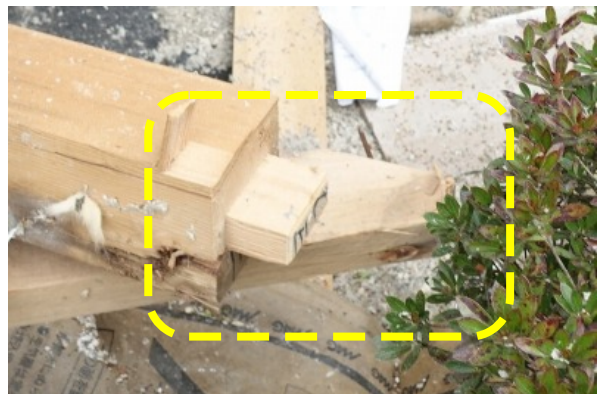
写真 5.3-51 柱頭部 (釘打ちによる接合)
