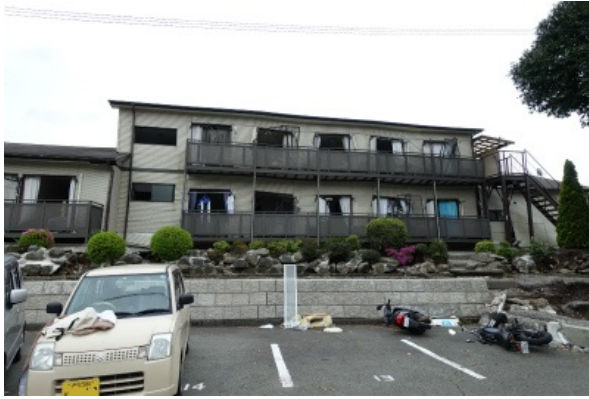
写真 5.3-62 大破した木造アパート
