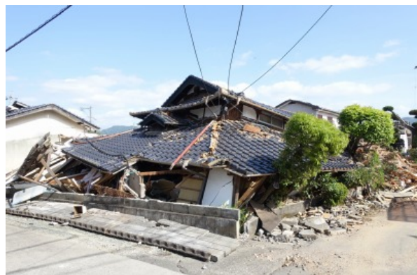
写真 5.3-3 倒壊した木造住宅
