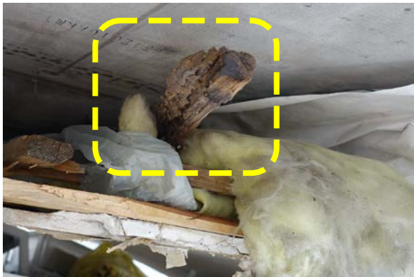
写真 5.3-48 アパート A の筋かい端部 (蟻害による著しい断面欠損)
