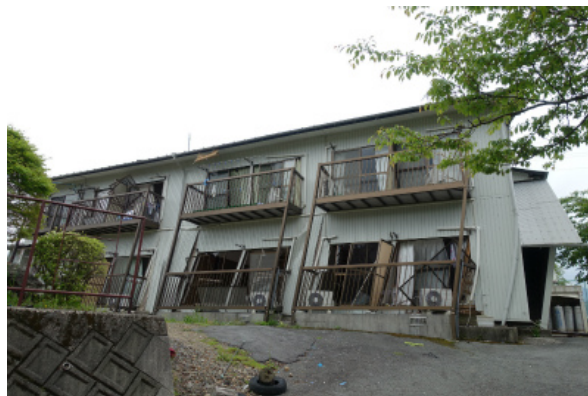
写真 5.3-61 傾斜した木造アパート
