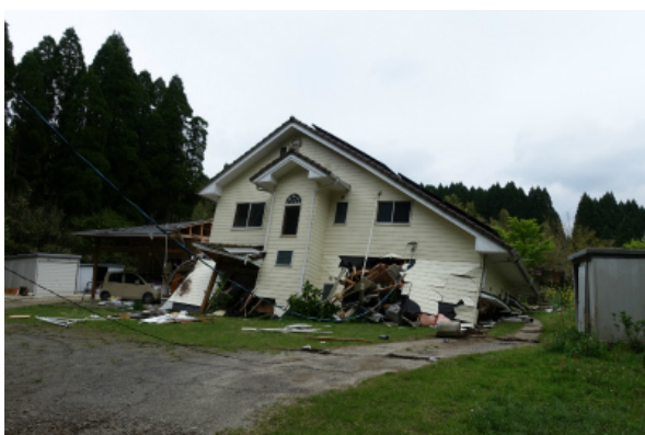
写真 5.3-68 倒壊した木造住宅（金物あり）
