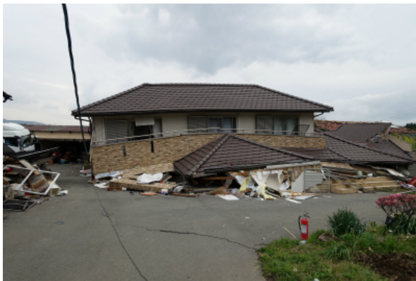
写真 5.3-70 倒壊した木造住宅（金物あり）
