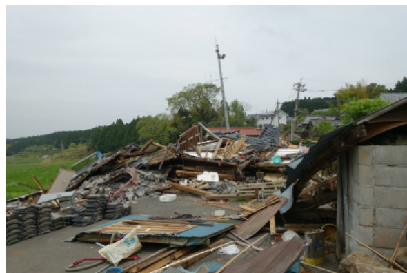
写真 5.3-37 倒壊した木造住宅
