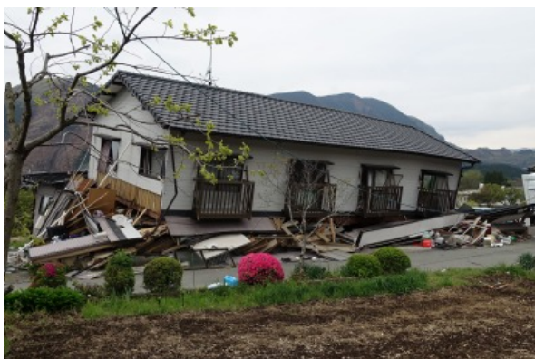
写真 5.3-58 倒壊した木造アパート
