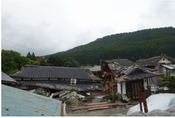
写真 5. 3-28 分離した木造住宅
