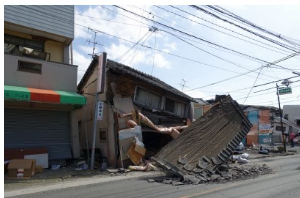
写真 5.3-5 倒壊した木造住宅
