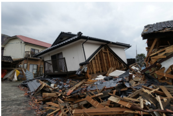
写真 5.3-66 倒壊した木造住宅
