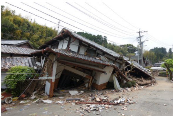
写真 5.3-36 倒壊した木造住宅
