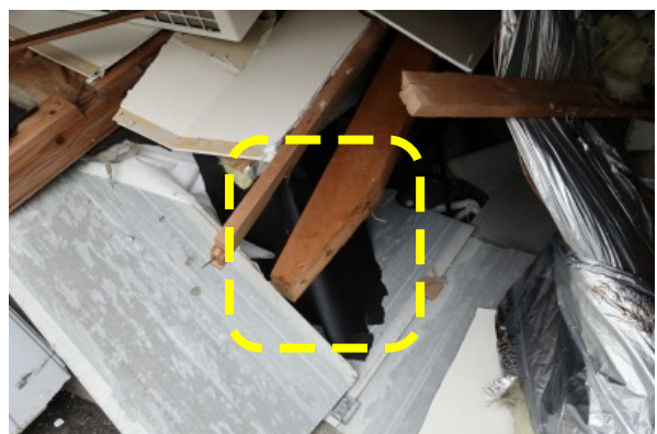
写真 5.3-53 アパート C の筋かい端部 (釘打ち)
