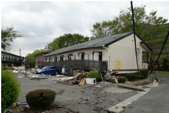
写真 5.3-50 倒壊したアパート B
