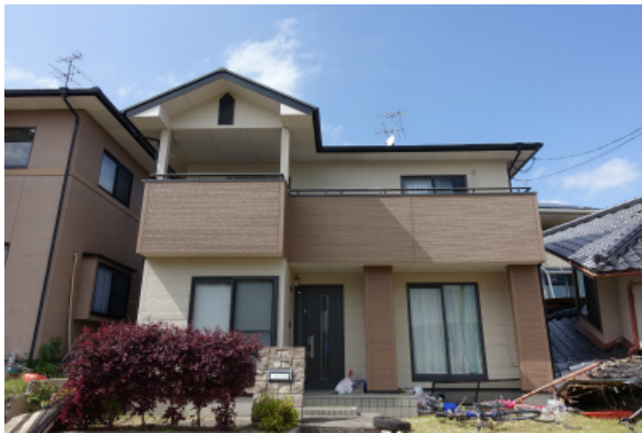
写真5.3-22 外観上無被害の木造住宅
