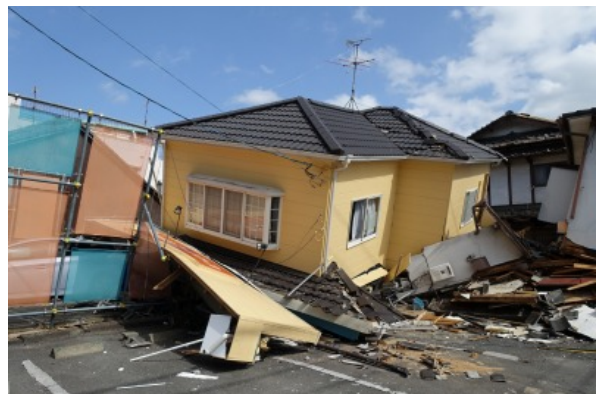
写真 5.3-11 倒壊した木造住宅
