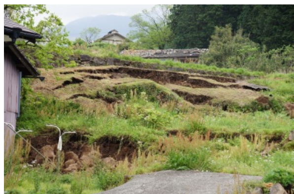
写真 5. 3-35 地盤に生じた亀裂
