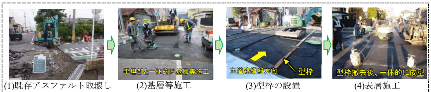
図－7 ヒアリング結果から得られた施工手順例
