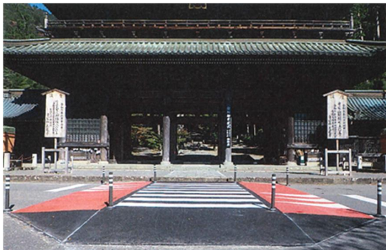
図-3 バリアフリーに配慮し歩道の高さをかさ上げしてハンプを設置した事例
