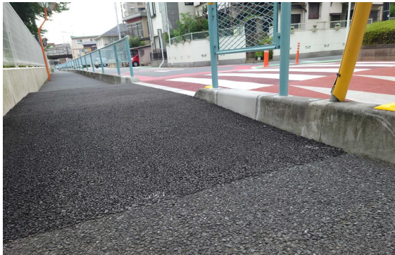
図-3 バリアフリーに配慮し歩道の高さをかさ上げしてハンプを設置した事例
