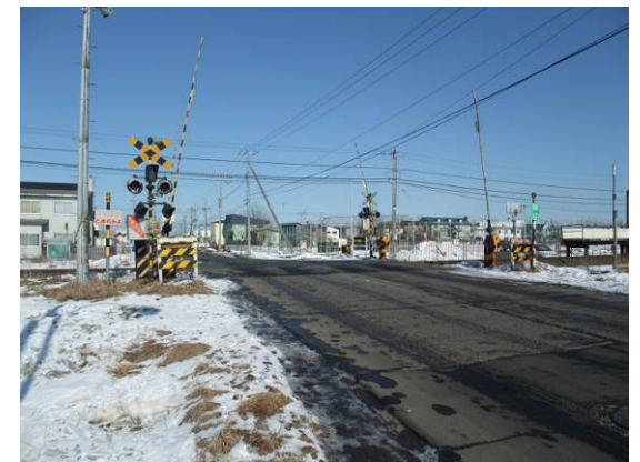
現在の踏切(海側から撮影)
