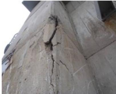
門柱部のコンクリート剥離等劣化状況
