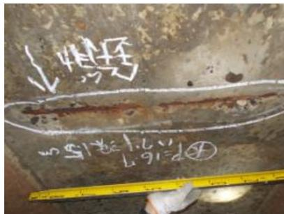
函体鉄筋の露出と腐食
