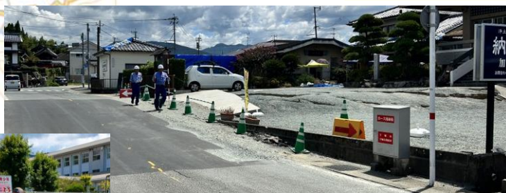
⑥宇城市小川町断層付近(配水管修繕箇所)
