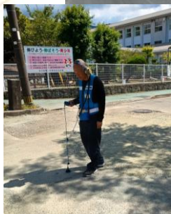
⑨支援団体職員による音響漏水調査
