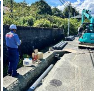
⑤宇城市小川町配水管布設
