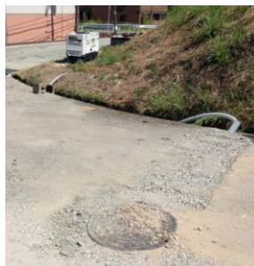
③宇城市小川町水中ポンプによる下水管バイパス
