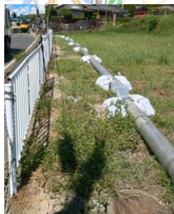
⑧氷川町上天草送水管(転がし配管)
