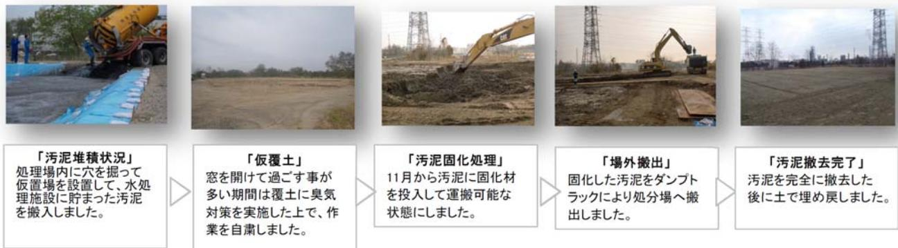
図 3.22 汚泥仮置き場の設置事例（宮城県仙塩浄化センター）
