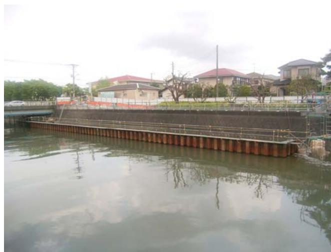
図 2.4 川の一部を締め切り簡易沈殿処理を行った事例（千葉県習志野市）
