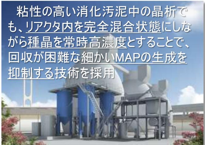
粘性の高い消化汚泥中の晶析でも、リアクタ内を完全混合状態にしながら種晶を常時高濃度とすることで、回収が困難な細かいMAPの生成を抑制する技術を採用
