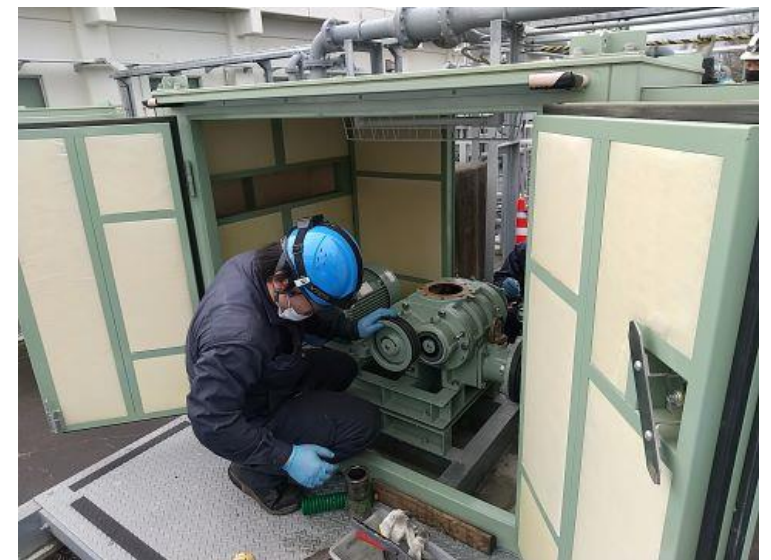
図 洗浄ブロワ分解点検
