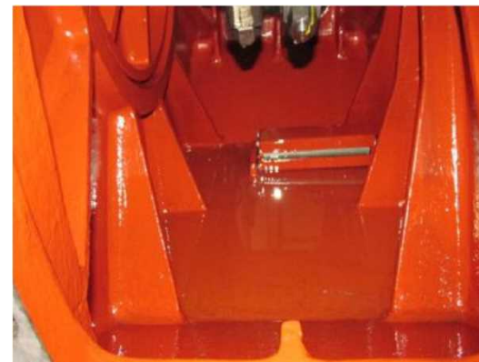
消化ガスコンプレッサー 潤滑油交換
