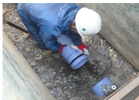
汚水管整備 (小山処理区)
