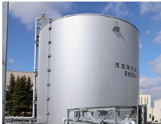
鋼板製消化タンク
