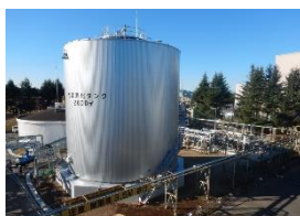
汚泥消化設備の整備
