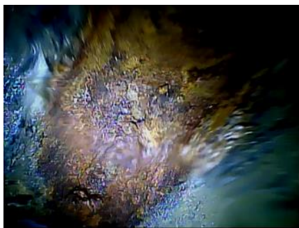
Aランク(鉄部腐食)
