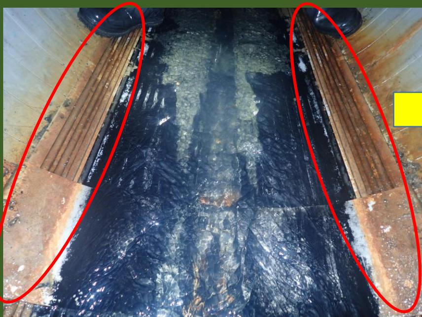
管路が古く、勾配の違いにより水面下に設置できない採熱管が発生。これにより、フルスペックでの採熱能力の検証が困難になった。
