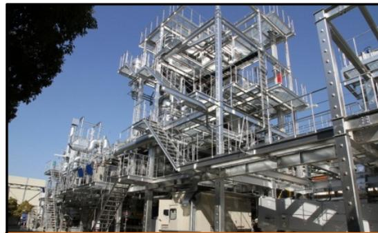
革新型階段炉+廃熱ボイラー
