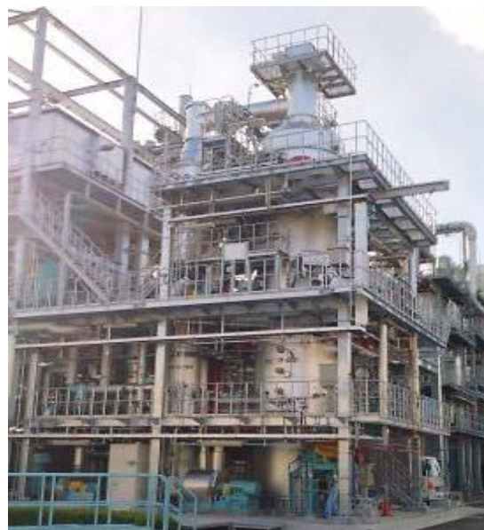
低空気比省エネ燃焼設備 (定格能力: 25t/d)
