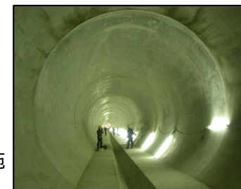
堀川右岸雨水滞水池
