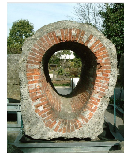
横浜市レンガ製下水管きょ (明治14年)
