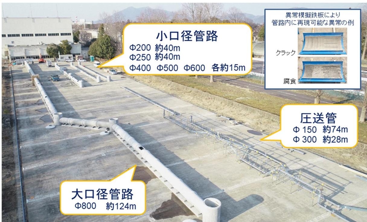
図-1 下水道管路模擬施設の概要
