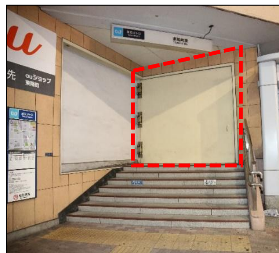
防水扉と階段によるかさ上げ
