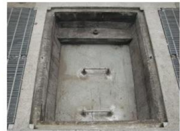
浸水防止機「閉」状態
