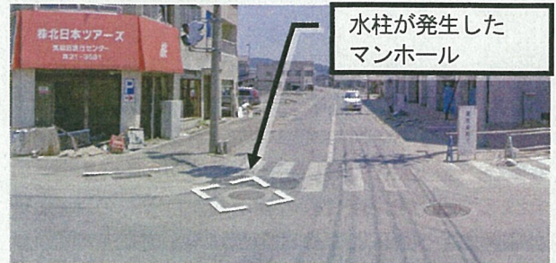
写真-4 水柱発生人孔周辺の震災後写真(平成23年7月時点のGoogleストリートビュー)
