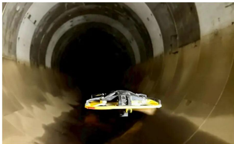
▲ 小型ドローンによる下水道管点検技術
