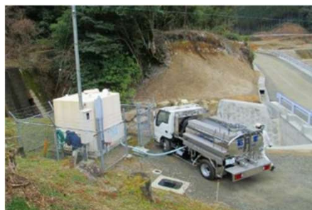
分散型システムの例 (給水車による運搬送水)
