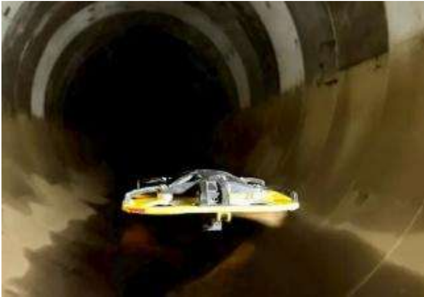
ドローンによる目視調査
