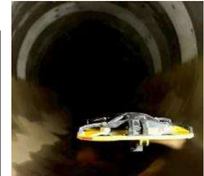
ドローンによる目視調査
