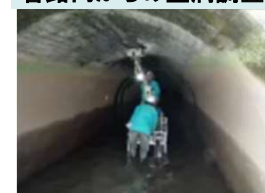
管路内からの空洞調査
