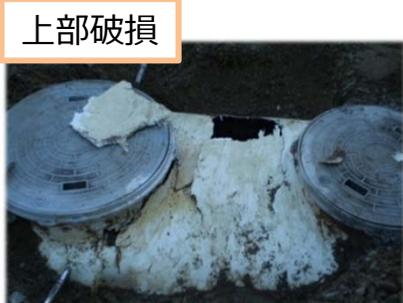
老朽化による破損や漏水等の事例が多く報告。(2016年度で約6,000件)生活排水の垂れ流しのみならず、公衆衛生に支障を生じる可能性。
