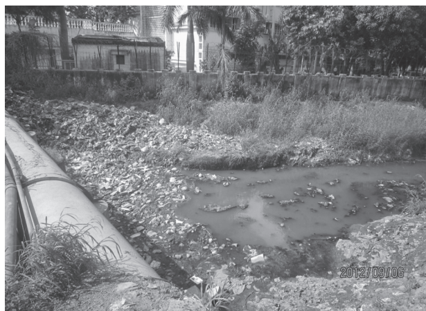
写真2 デリー中心部の水路の水質状況(2012年9月6日筆者撮影)
