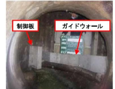
渦流を発生させ、ゴミなどを処理場側の管渠に吸い込ませることで、河川等への流出を抑制
