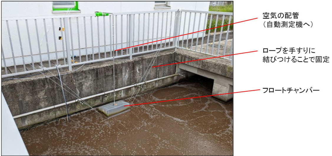
写真 4.4 フロートチャンバー設置の例
