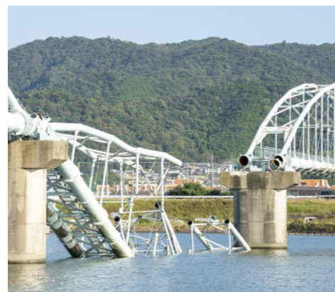
水管橋（和歌山市）
