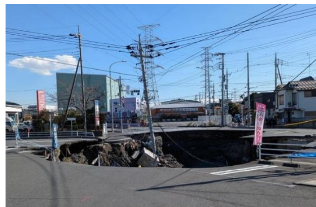
大口径下水道管（埼玉県八潮市）
