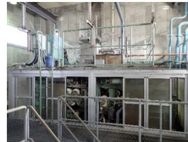
ベルトプレス脱水機(実機)
