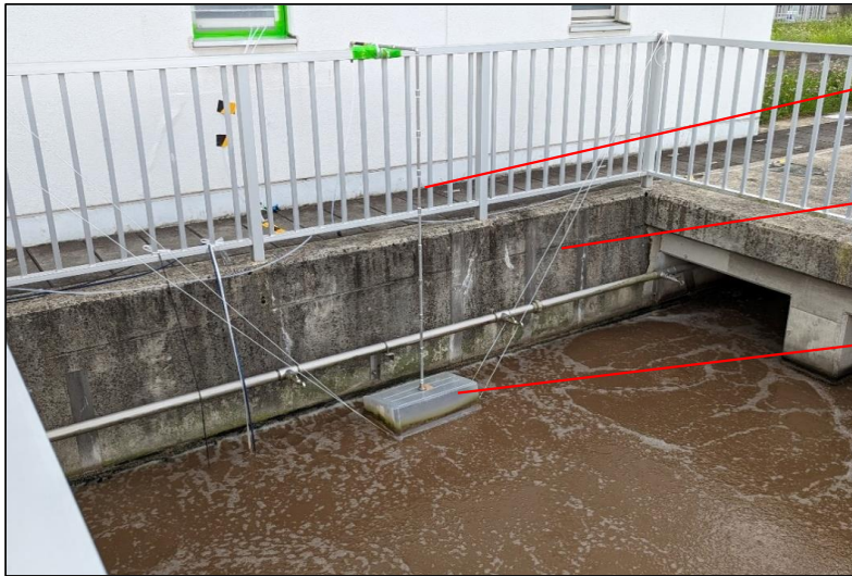
写真 4.4 フロートチャンバー設置の例
