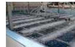
超微細散気装置導入による省エネ化 (〇〇〇t-CO 2 削減)
