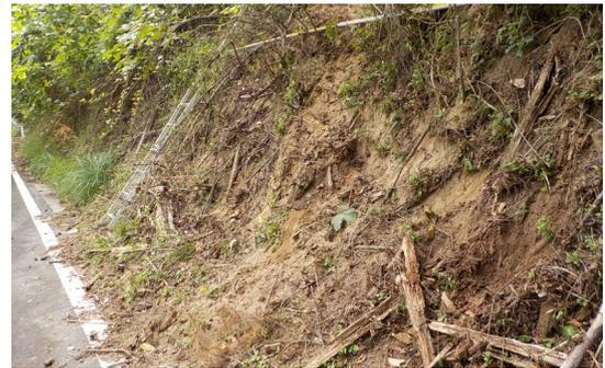
写真-1 イノシシによる植生剥離と基盤流出
