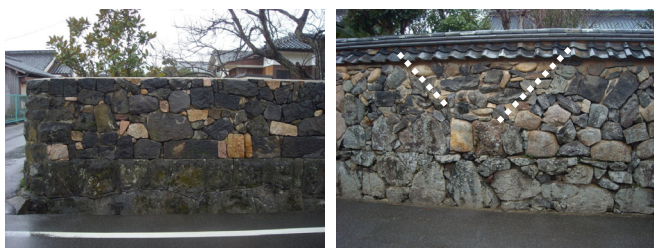
写真-3 全面改修実施区間 写真-4 部分改修実施区間 V字の白線内を改修
