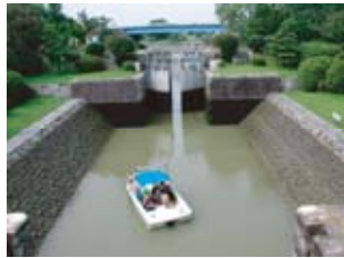
54 木曾川・船頭平閘門
