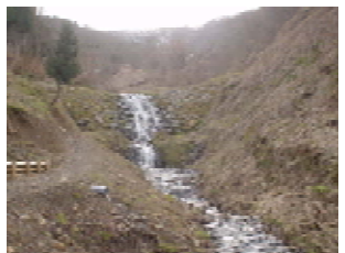
69 赤谷川・アカタン砂防堰堤群
