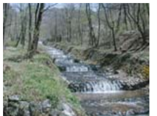
70 牛伏川・フランス式階段工
