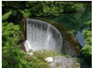
68 大源太川第1号砂防堰堤
