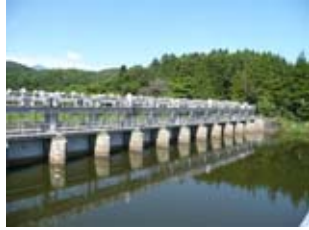
42 安積疏水十六橋水門
