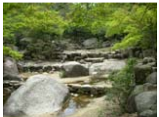
77 紅葉谷川庭園砂防
