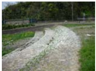
78 大谷川砂防堰堤
