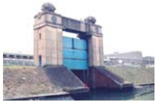
49 多摩川・川崎河港水門
