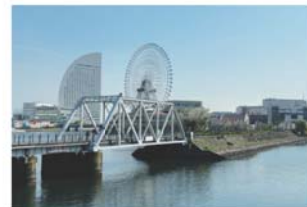
汽車道・港一橋
