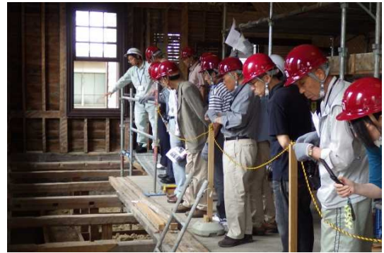
■旧伊達郡役所修理事業現場見学会
