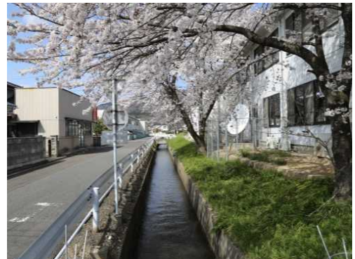
■現在の西根上堰(役場付近)
