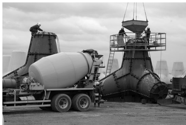
写真 3. 2-17 異形ブロック型枠(テトラポット)
