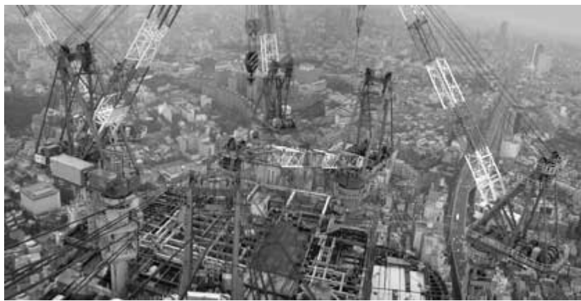
写真 3. 2-10 タワークレーン
