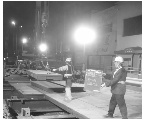
写真 3. 2-16 覆工板(設置状況)
