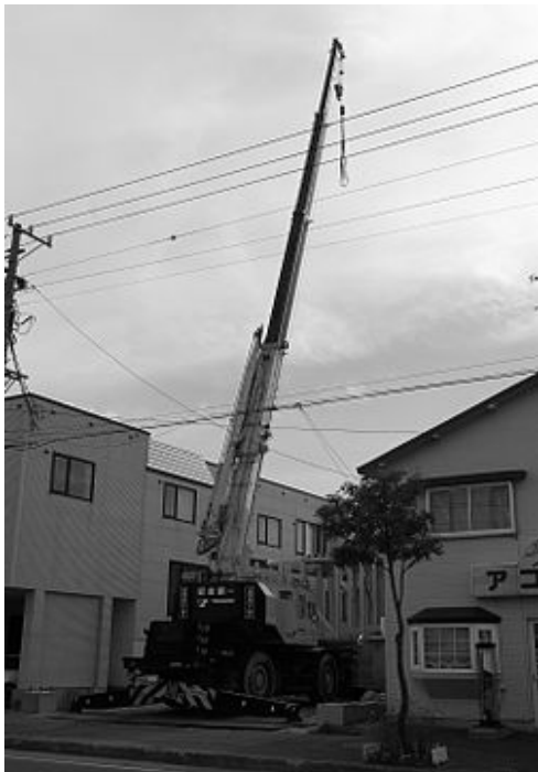
写真 3. 2-6 ラフテレーンクレーン
