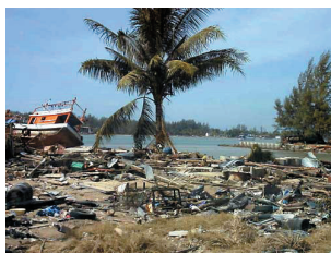
スマトラ島沖地震及びインド洋津波による沿岸域の被災状況
