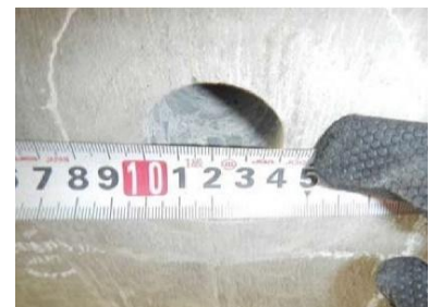
参写真-2.2.2 削孔径確認
