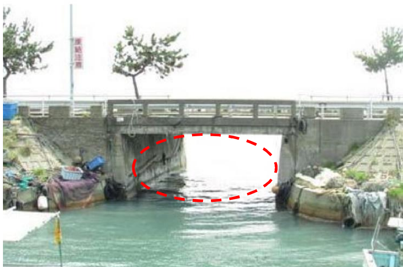
写真-2.2.1 陸上から桁下へのアクセスが困難な条件の例
